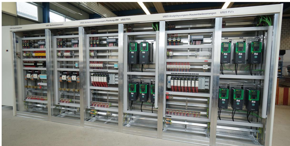
Der abgebildete Anlagenteil beinhaltet die Komponenten für das Spülluftgebläse, die Spülwasserpumpen, die Schlammwasserpumpen + Flockung + Brauchwasser sowie die Analytikpumpen + Hausentwässerungen.
